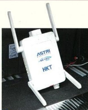
● 路旁設備安裝香港電訊的基站。
